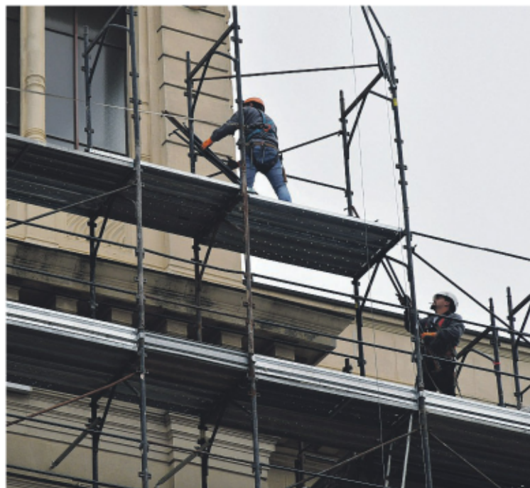
Operai al lavoro su un'impalcatura
